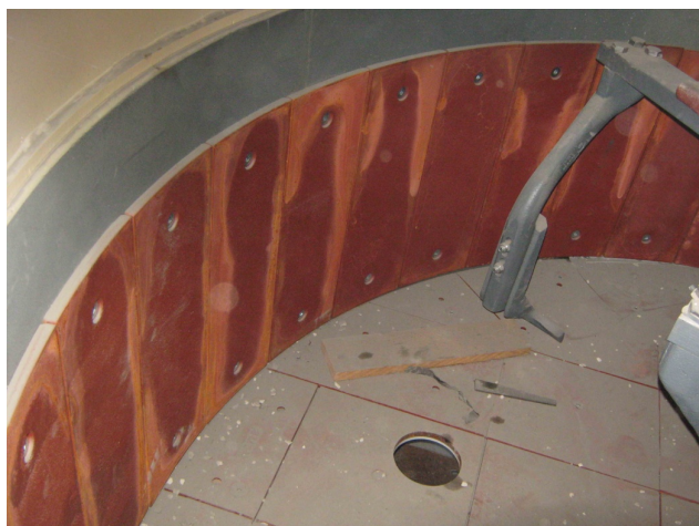
Рисунок 3. Пример выполнения отверстия в полу бетоносмесителя
