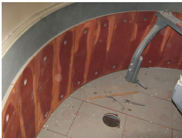
Рисунок 3. Пример выполнения отверстия в полу бетоносмесителя.
